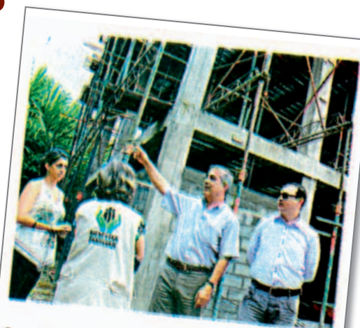
Las obras serán entregadas el próximo 11 de abril a las 9:00 de la mañana.
