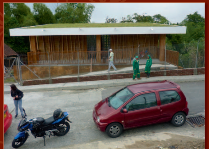
Eingang oben an der Schule (Straßenseite)
