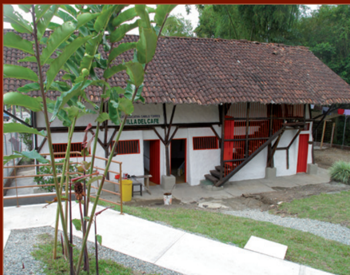
Unsere „alte“, im Jahr 2001 übergebene Schule, wurde renoviert
