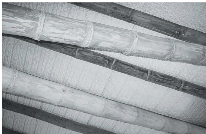
Dachbalken aus Guadua, darunter eine Beschichtung aus Drahtgeflecht und Mörtel. Diese Art zu bauen ist wesentlich angenehmer als die frühere Lehmabauweise Foto: E. Pape
