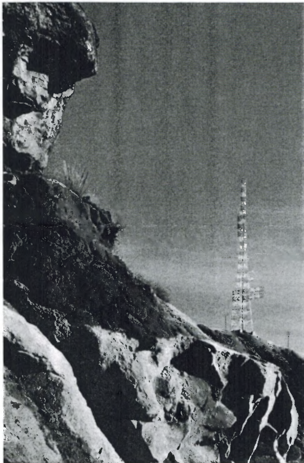
Bild 4 Station auf dem 4200 m hohen El Ruiz. Am etwa 100 m hohen Mast sind die horizontal angebrachten 24 Achterfelder in Richtung Las Jurisdicciones zu erkennen
