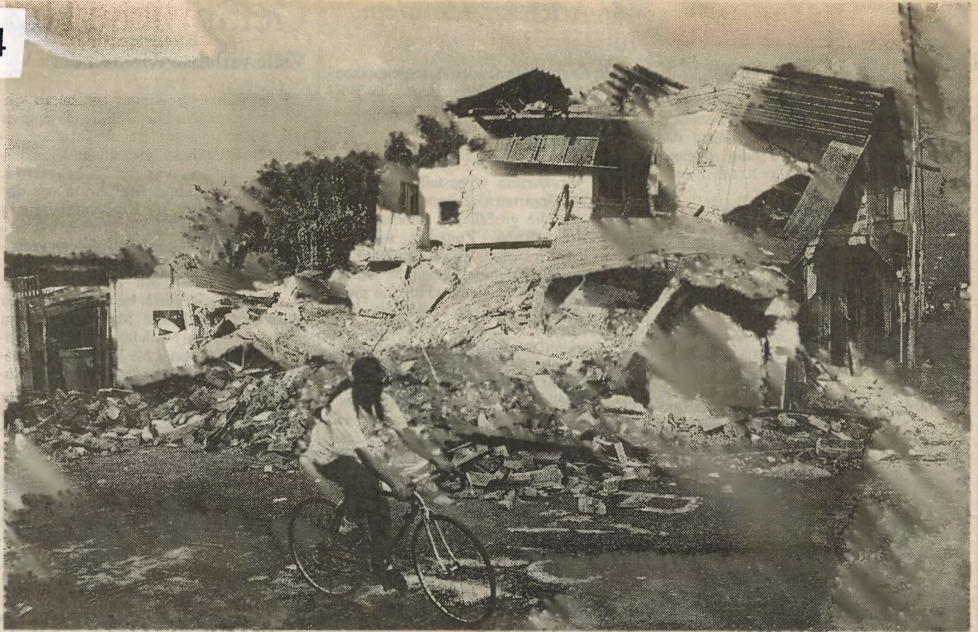
Zerstörte Häuser in der kolumbianischen Ortschaft La Tebaida nach dem Erdbeben vom 25. Januar.
