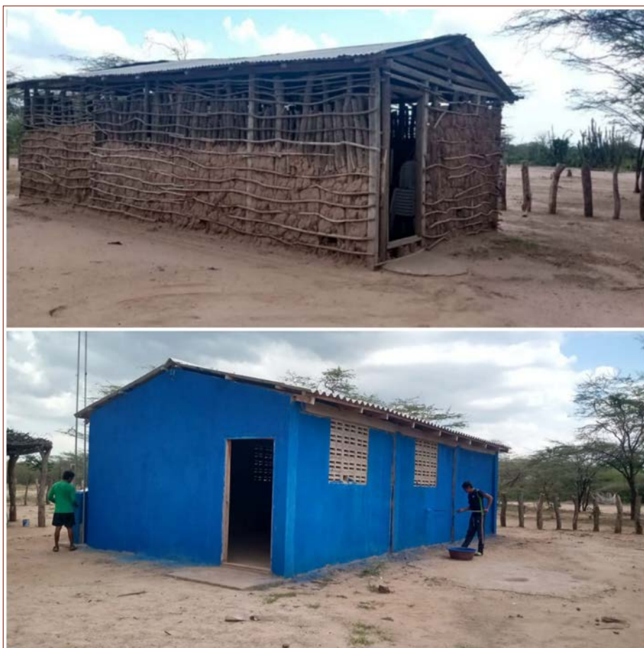
Schule für die Wayuu-Kinder in Alainawao (oben der alte, heute als Küche und Lager genutzte Bau, unten das 2020 fertiggestellte Schulhaus)
