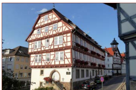
Wolfhagen: monumentales Fachwerkhaus
