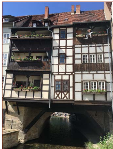
Fachwerk an der Südseite der famosen Krämerbrücke
