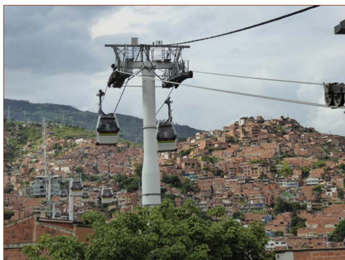
Seilbahnsystem „metro cable“; Medellín, dpto. de Antioquia
