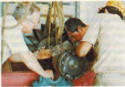
Endmontage der Turbine für die Kleinwasserkraftanlage Palmor.
