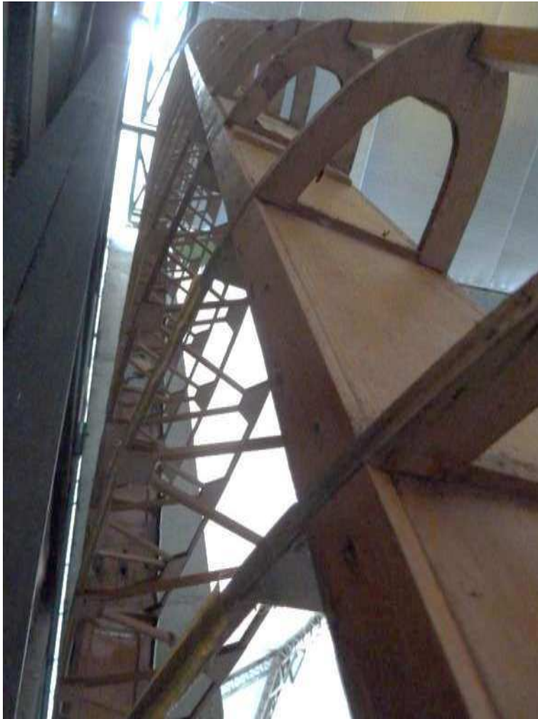
Estructura de ala en madera, el primer material compuesto y el paradigma de plásticos compuestos de fibras de vidrio o carbono con resina sintética, Foto S. Ritt
